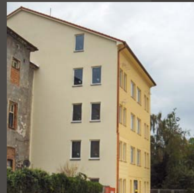
Administrativní budova Petáková ul. 5, Plzeň
